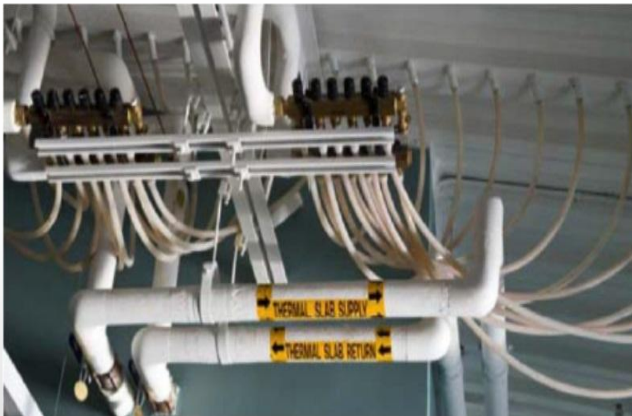
سیستم گرمایش و سرمایش تشعشعی از سقف
